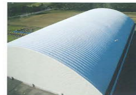
小学校体育館 (福井県) 瓦構屋根 (遮熱・防食)
