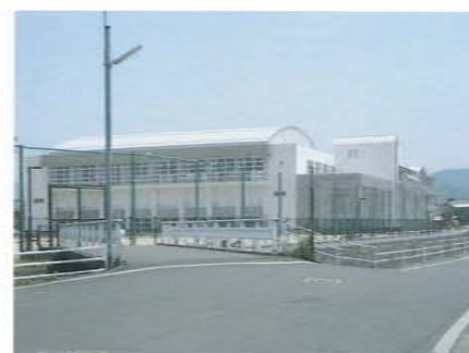
中学校 (福井県) 銅板屋根 (遮熱)
