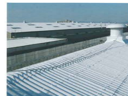
新日鐵住金工場 (兵庫県) 強度アップ (遮熱)
