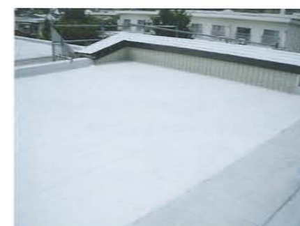
屋上防水 (愛知県) アスファルト防水 (防水遮熱保護)
