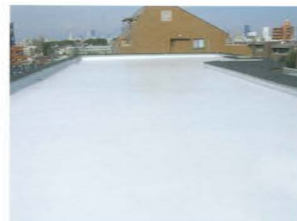
マンション屋上 (愛知県) シート防水 (防水遮熱保護)
