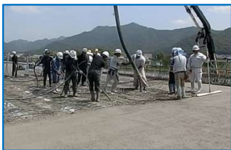
①コンクリート打設
