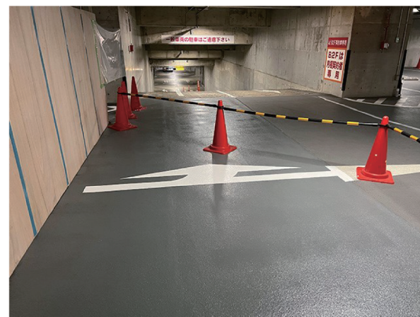
施工完了③
