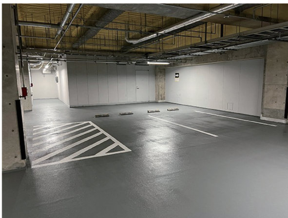
施工完了①
