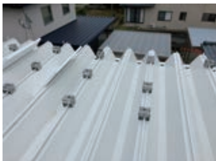
②取付金具設置
