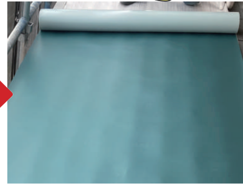
塩ビシート敷設
