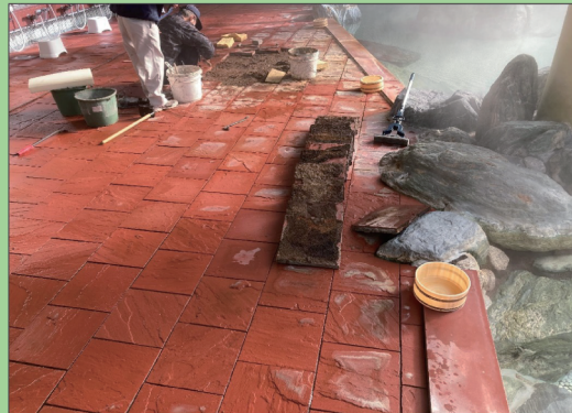
②既存タイル撤去
