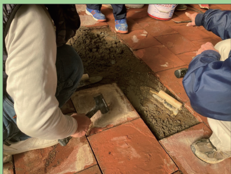
④下地処理
