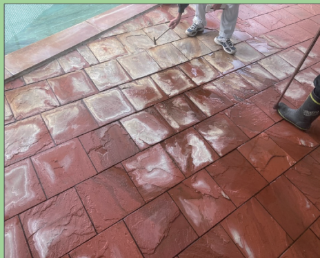
①洗い場土間タイル 施工前
