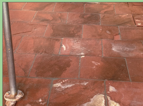
⑥施工完了
