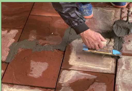
⑤既存タイル復旧後(目地詰め)
