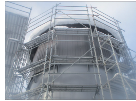
⑤外壁板金
