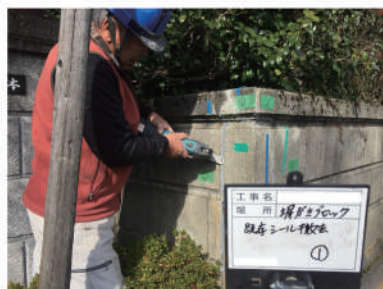
①既存シール撤去
