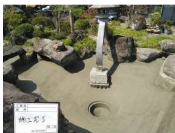
⑨樹脂モルタル塗布 2 層目
