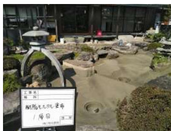
③樹脂モルタル塗布 1 層目
