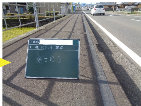
④ 施工完了
