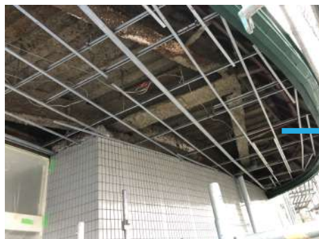
既設軒天板撤去・処分
