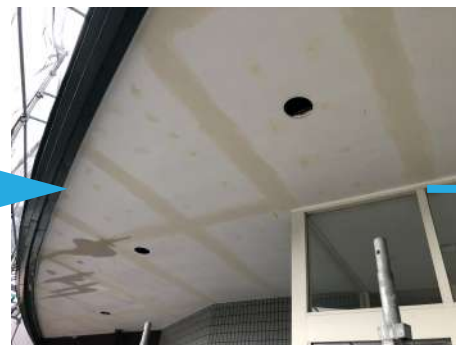
軒天板塗装工事
