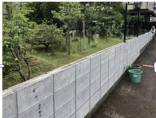
⑤フェンス柱設置
