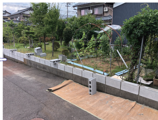
③コンクリートブロック積み施工中
