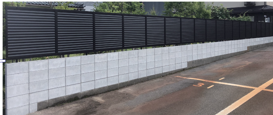
⑥施工完了
