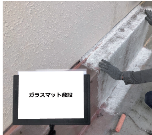
ガラスマット敷設
