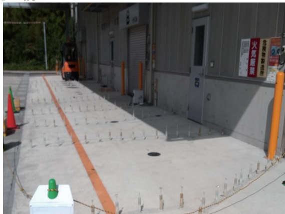
②樹脂注入
