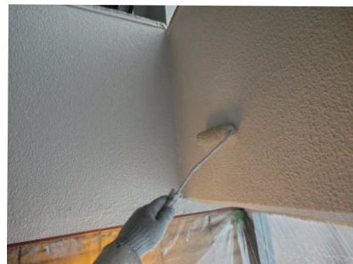
⑦外壁塗装
