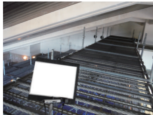
③棚足場組立
