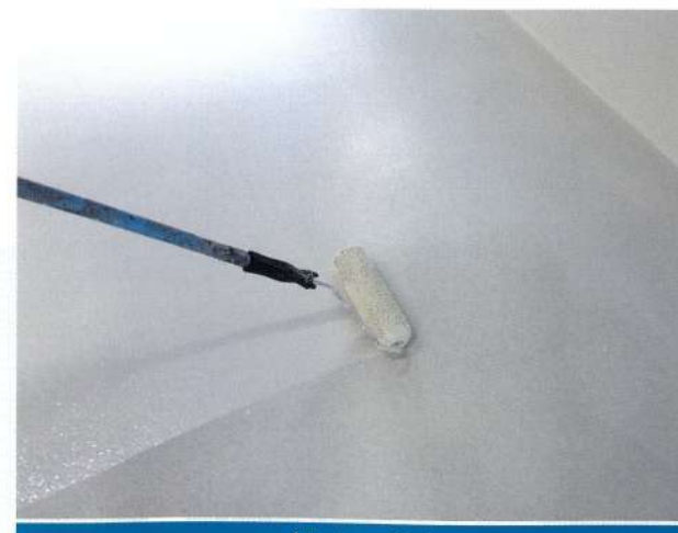
プライマー塗布
