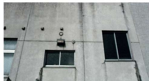
屋根だけでなく高所の壁面も撮影が可能
