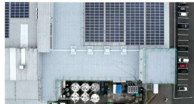
高所の点検・確認が可能
