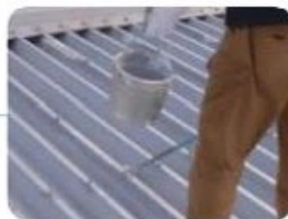
プライマー塗布
