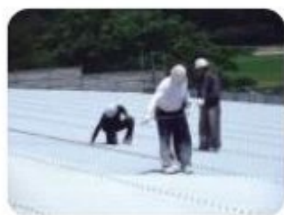
ベース材吹付け
