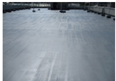
⑥工事完了
