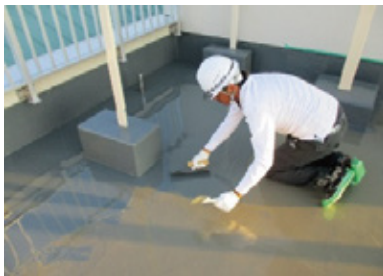
④防水材塗布作業
