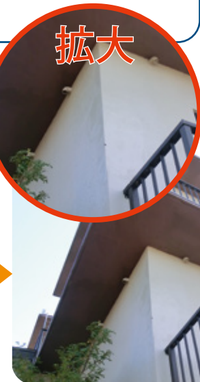
外壁補修完了
