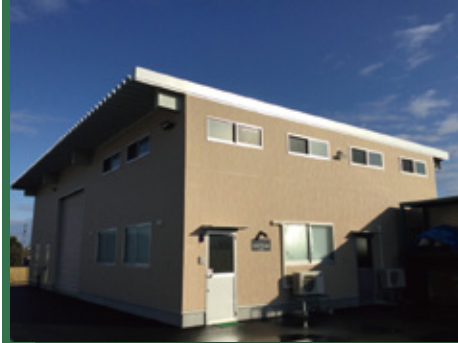
▲完成した研究室
