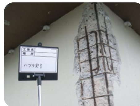
外壁削り完了
