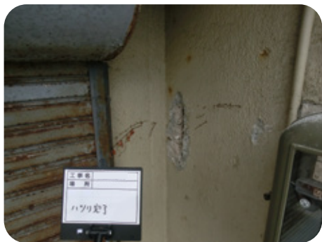
外壁ハツリ完了
