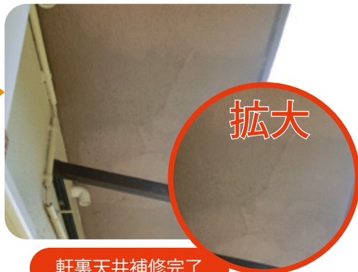
軒裏天井補修完了
