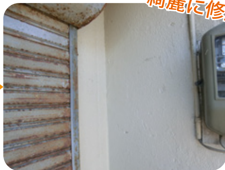
外壁補修完了
