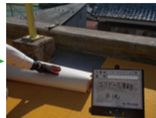
コリドール貼り状況
