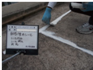
目地埋めシール状況
