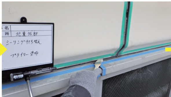
プライマー塗布
