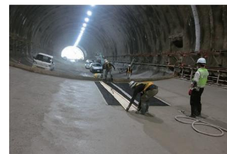
写真4 施工例・トンネルインバート
