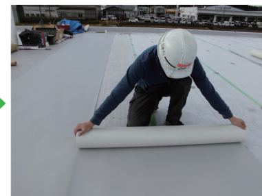
④塩ビシート敷設
