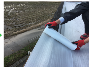
②絶縁シート敷設
