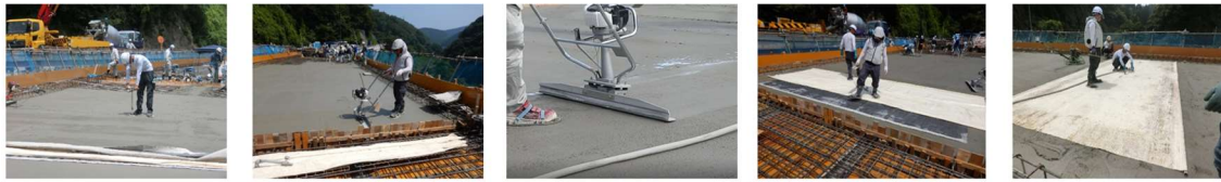
貫入値測定 → 振動スクリードで表面再振動(施工範囲全面行う) → 真空マット敷設 → 真空脱水
