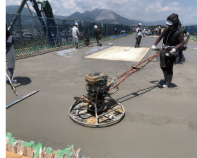
④仕上げ作業
