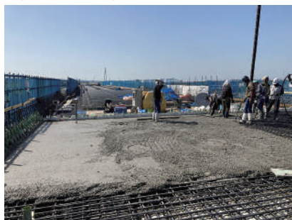
①コンクリート打設
