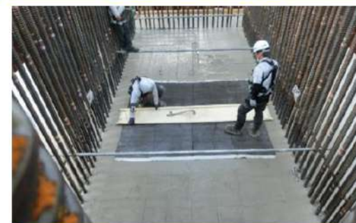
真空脱水作業
