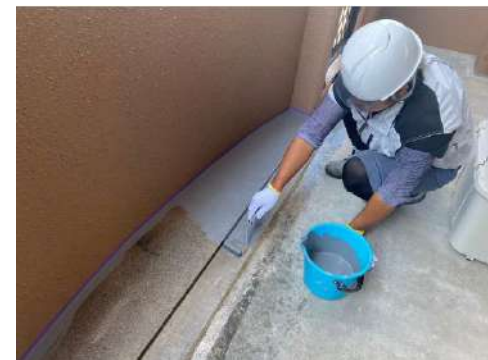
④既存側溝部はウレタン塗膜防水で 漏水の心配も無くなります。
