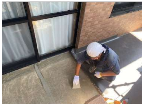
①高圧洗浄で苔や泥等の撤去後、既存目地埋め(不陸調整)し、凸凹段差回避から接着剤を塗布
