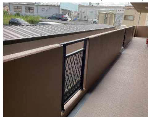
⑤施工完了
