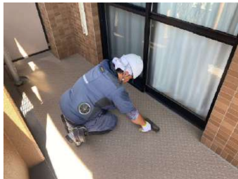
②長尺シート敷設 シートのシワやタワミにならないよう 隅々までローラー押え(重要作業)
