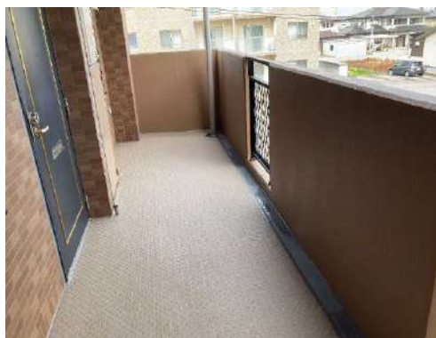
①高圧洗浄で苔や泥等の撤去後、既存目地埋め(不陸調整)し、凸凹段差回避から接着剤を塗布
