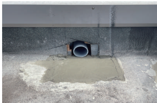
②配管を通し、水が流れるように勾配調整
