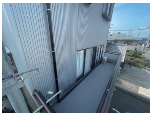
⑤屋上から水はベランダ排水溝へ
