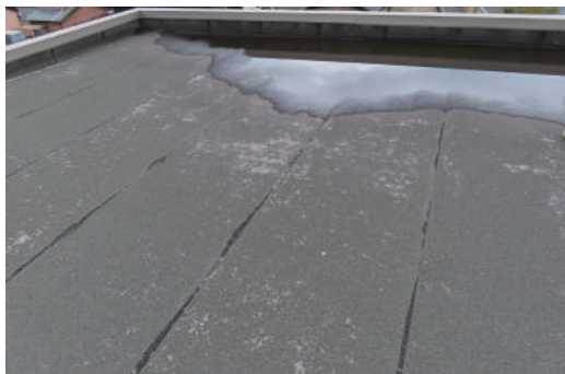
①屋上施工前
