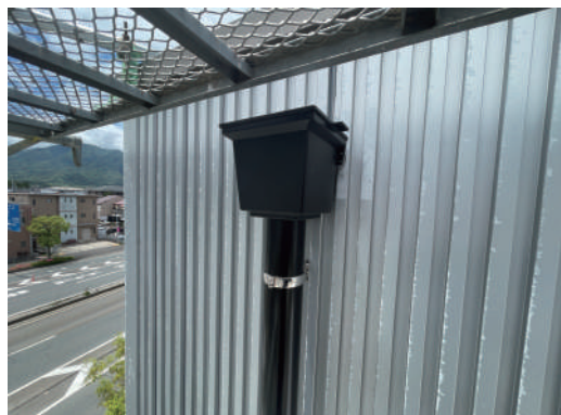
④外壁に雨樋を新設
